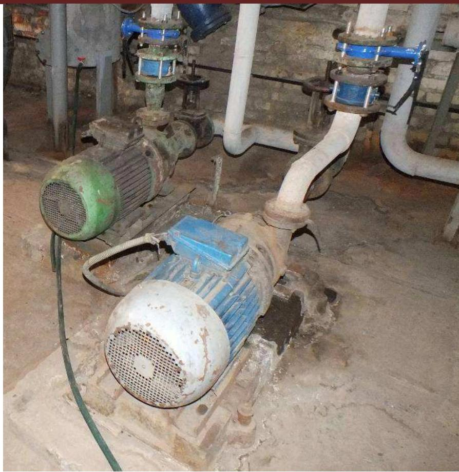
**Рисунок 2.1.2.7.6 – Насосы ГВС (большой контур)**
