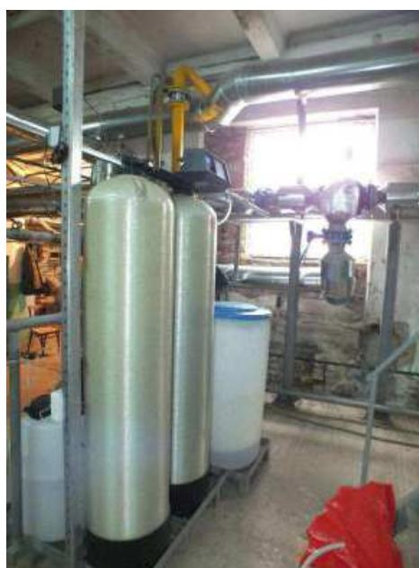
**Рисунок 2.1.2.7.7 – Система водоподготовки**
